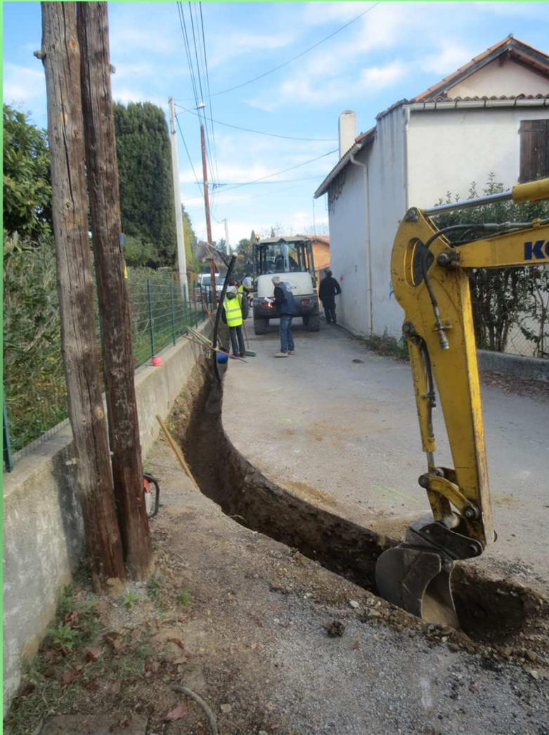
Pose de conduites en tranchée sous voiries (chemin du Prêche)
