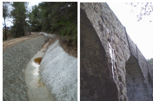
Tronçon du canal maître à Ganagobie après travaux
