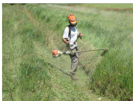
Débroussaillage d'une filiole de Manosque pendant la saison d'arrosage nécessitant une mise à sec créalable – Photo BTP Consultants
