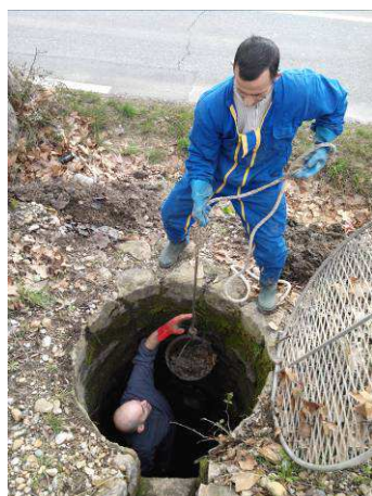
Nettoyage d'un puisard
