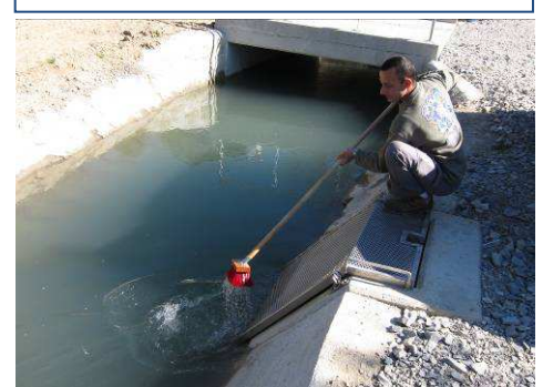
Nettoyage de la grille en tête de la prise d'eau qui alimente un réseau basse pression à Manosque – Photo BTP Consultants
