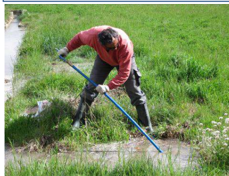
Débouchage de la filiole n°14 de Peyruis – Photo BTP Consultants
