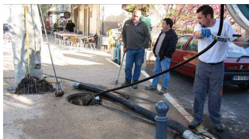
Débouchage d'un puisard bouché par les racines de l'arbre riverain, à Volx, par l'entreprise AQUAPROVENCE – Photo BTP Consultants
