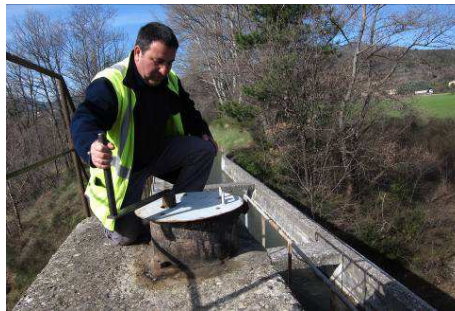
Manœuvre de la vidange de l'aqueduc du Mardaric à Peyruis – Photo BTP Consultants
