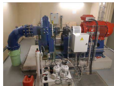
La turbine et ses équipements
