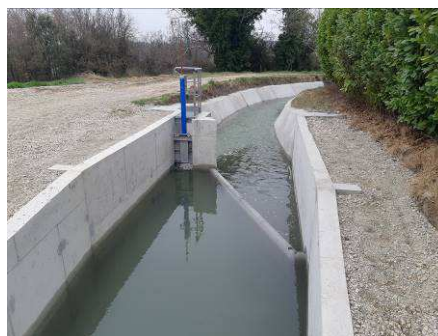
Construction de l'ouvrage de génie-civil du seuil de Manosque Ouest (GAGNERAUD / MINETTO)
