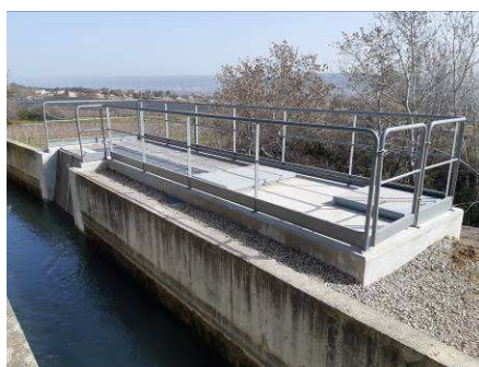
Mise en place de béton double fibre sur les bajoyers par plots alternés, coulage du radier, traitement de la piste d'exploitation et sécurisation à Sainte-Tulle, Costebelle (CHAPUS)
