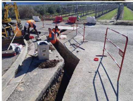
Regard de prise, conduites et bornes d'irrigation à Villeneuve (BUCCI / CER)
