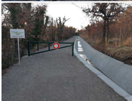
Mise en place de béton double fibre sur les bajoyers par plots alternés, coulage du radier, traitement de la piste d'exploitation et sécurisation à Sainte-Tulle, Costebelle (CHAPUS)
