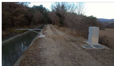
Mise en place d'instrumentations sur le canal maître
