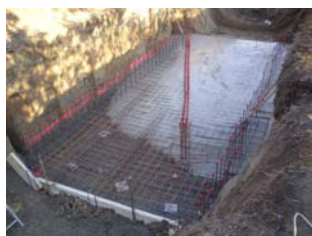
Seuil hydraulique Coulage du radier
