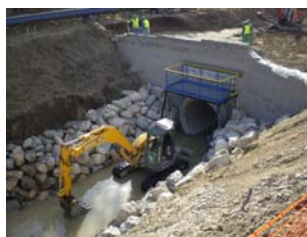
Site SILPRO Tête amont du canal busé avec déorilleur
