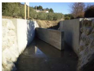
Seuil hydraulique Gros oeuvre terminé sans les équipements
