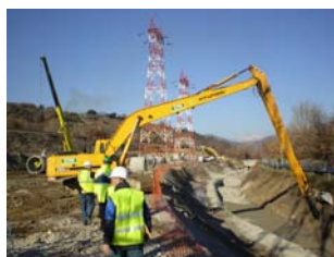
Site SILPRO Canal busé sous remblai
