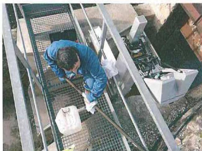
*A gauche et en haut : Nettoyage annuel des prises d'eau et des équipements sur canal maître et pompage/inspection des siphons (ASCM)*
