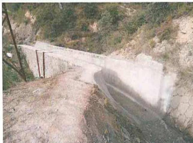
*Réhabilitation de l'étanchéité d'un aqueduc par décroutage et réfection de la cunette interne avec un enduit étanche projeté sur structure grillagée (ent. PAGLIANO/MORELLO)*
