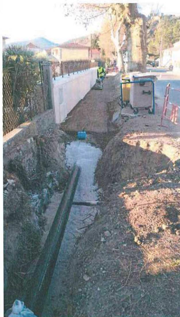
Pose du réseau d'irrigation PEHD sous voiries communales, en traversée de RD4096 et dans l'emprise d'une ancienne filiole (entreprise MINETTO)
