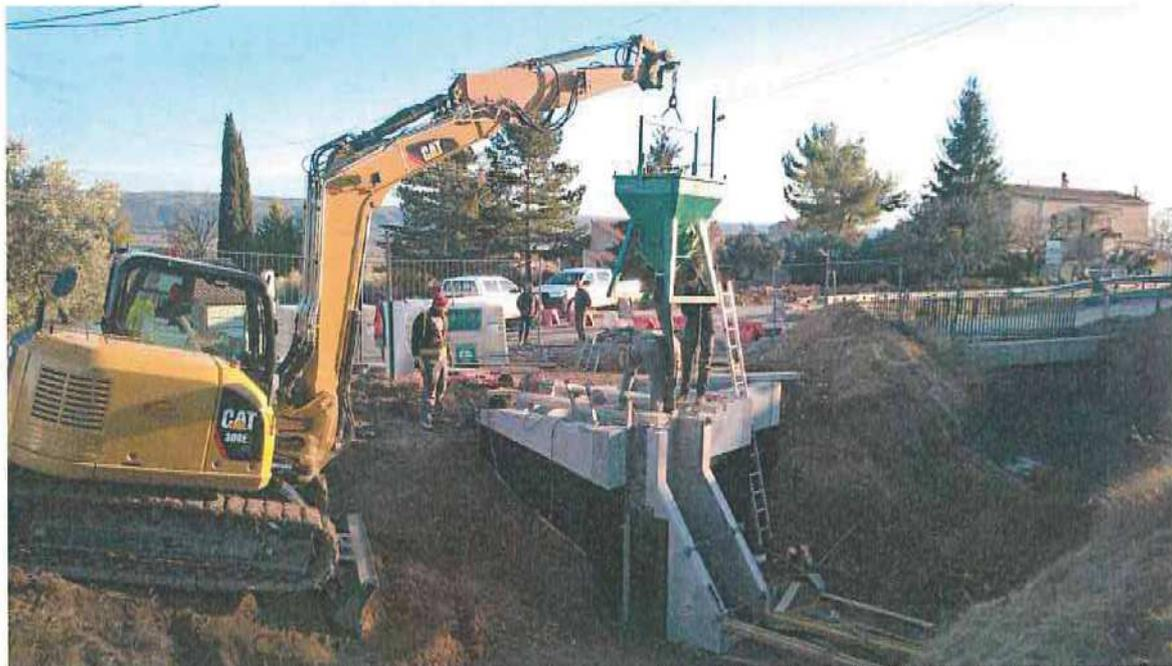
Réalisation de l'ouvrage de prise (terrassement et pose des éléments préfabriqués (entreprise BUCCI)
