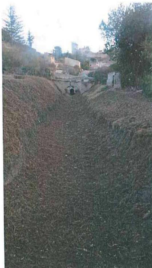
*Opérations de débroussaillage mécanique et manuel sur canal maître en secteurs difficiles d'accès (ent. BOURRELLY)*
