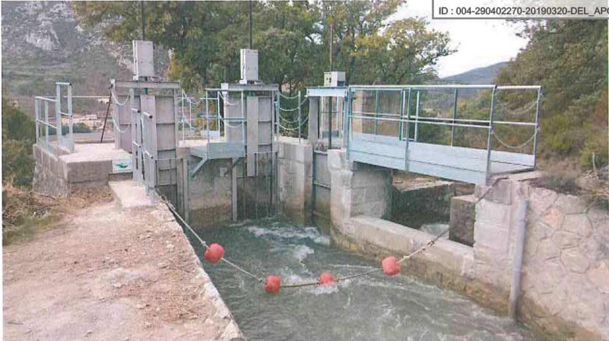
*Reprise des maçonneries et dalles de couverture des ouvrages intermédiaires, confortement du coursier de vidange et des accessoires de sécurité de la tête amont (vannes de sectionnement, passerelle, garde-corps)*
