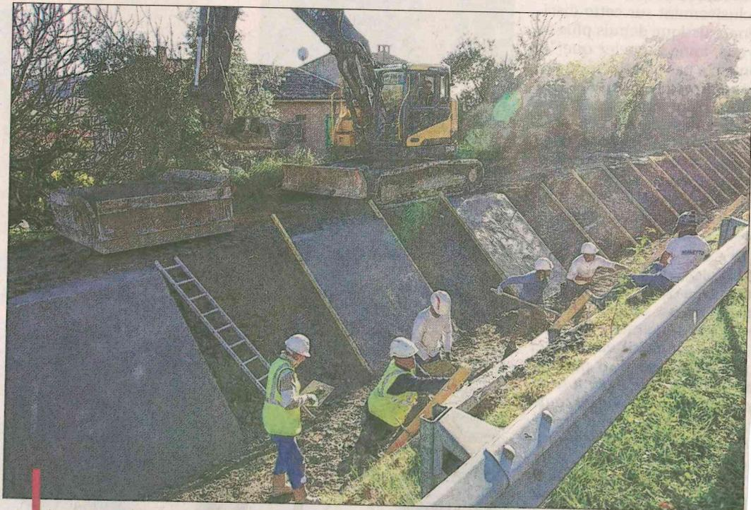
La quarantaine de travaux de maintenance actuellement réalisés permet notamment de reprofiler 1 200 m de canal en bétonnant ses flancs et son radier (le fond) avec du béton fibré.
