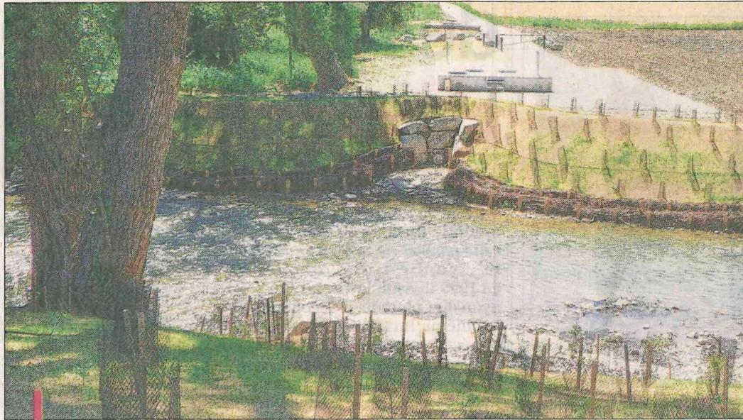
Grâce aux travaux d'approfondissement des deux conduites forcées, le seuil en traversée du Largue a pu être supprimé, entre des berges restaurées et revégétalisées, à Villeneuve. / PHOTO F.R.
