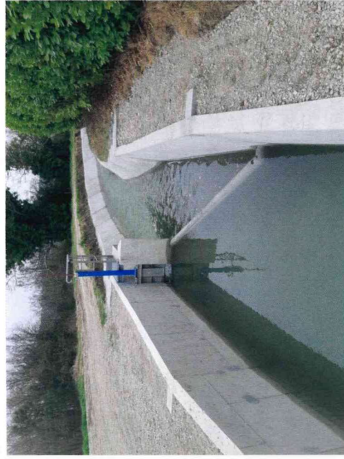
Exemple d'un seuil fixe transversal sur la Canal Maître à Manosque
