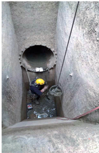
Curage des puits des têtes amont et aval
