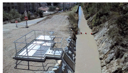
Prise du nouveau réseau basse pression à Peyruis, La Roche
