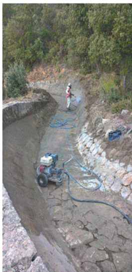
Nettoyage et décaissage des joints du canal de décharge
