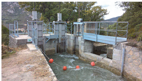
Reprise des perrés, des maçonneries et des accessoires de sécurité de la tête amont (passerelle, gardes-corps)
