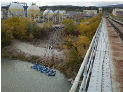
En aval du site SILPRO, au niveau de l'usine ARKEMA, le canal de Manosque est réalimenté par pompage en Durance
